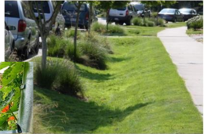
Figur 21: Fordrøyning og infiltrasjon i gresskleddeskanne langs gater, kalt vadi (Foto: Erling Holm ©)
